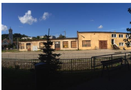
Zdj. Stan techniczny budynków na Zagórzu – w rejonie ul. Sabata
