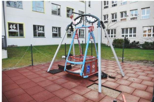
Montaż huśtawki dla dzieci z niepełnosprawnościami w SP-6
