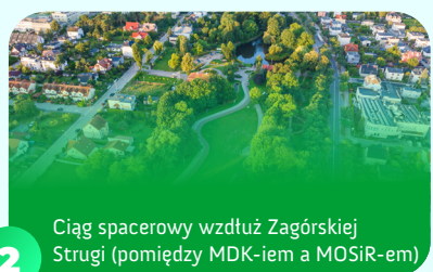
2 Ciąg spacerowy wzdłuż Zagórskiej Strugi (pomiędzy MDK-iem a MOSiR-em)
