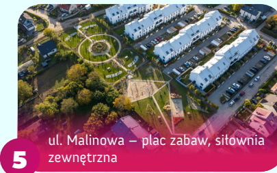
5 ul. Malinowa – plac zabaw, siłownia zewnętrzna
