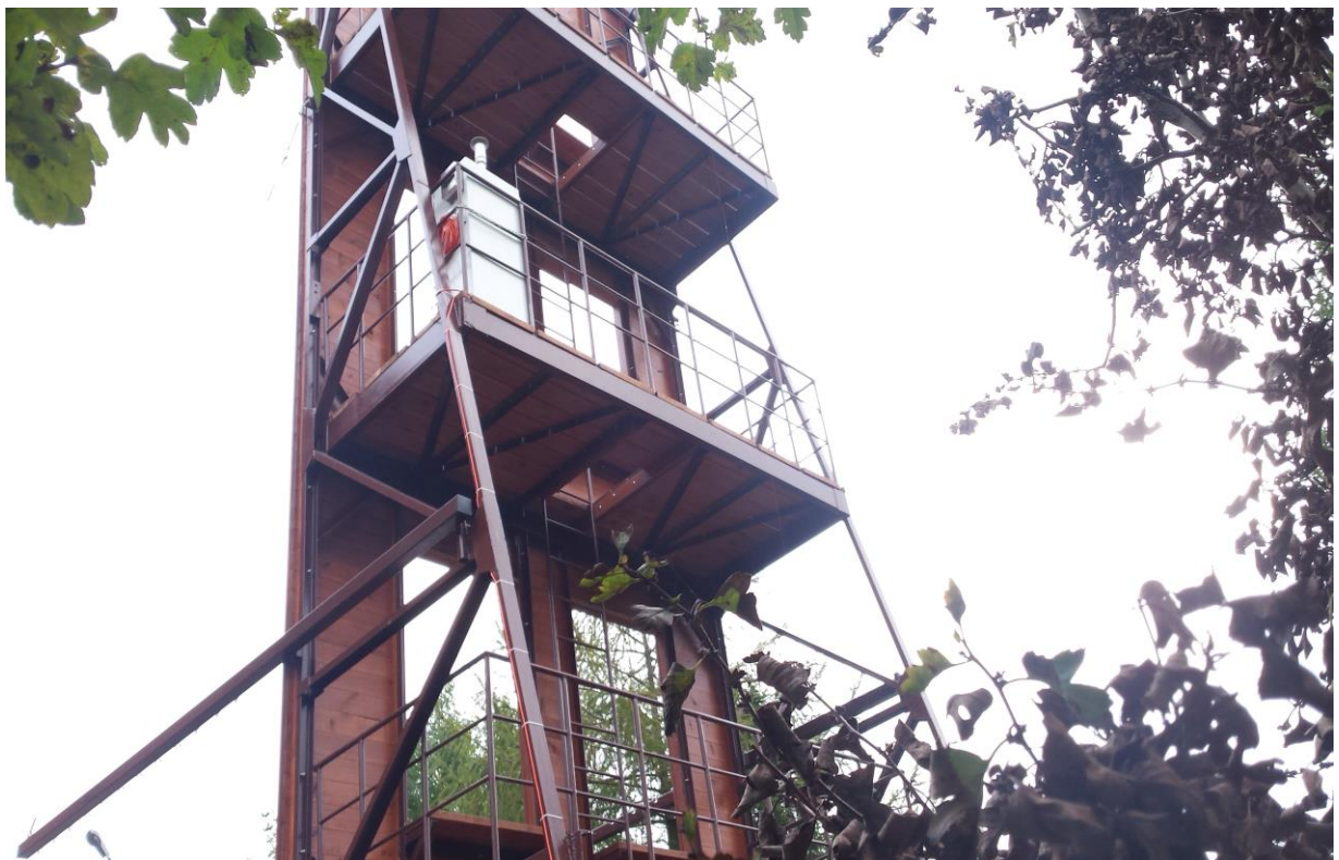
Ryc.5 Zainstalowany pobornik w Rumi przy ul. Plac Kaszubski 1
