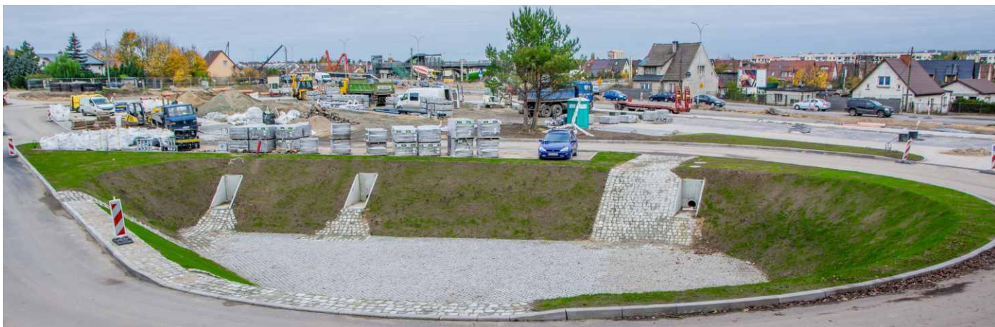
Zbiornik rozsączający przy węźle
