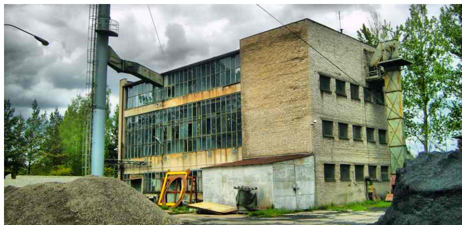
Stary budynek ciepłowni do modernizacji
