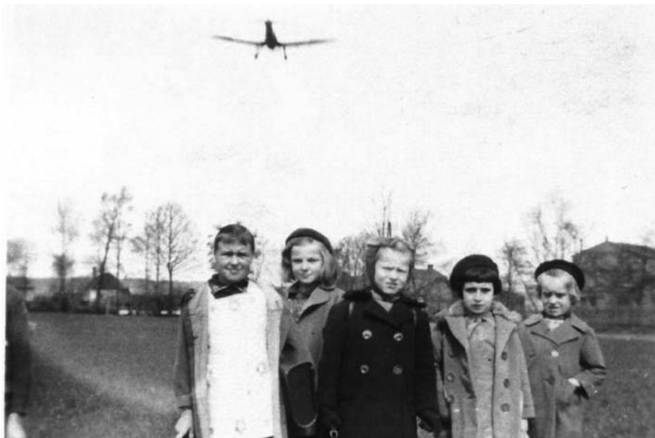
Rumia, 1935 roku. Na zdjęciu po prawej budynek Straży Pożarnej
