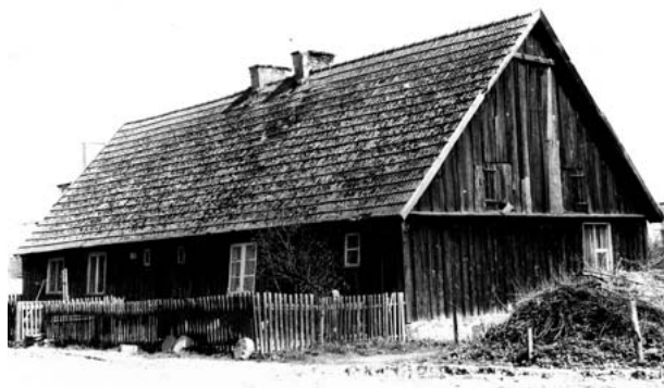
Rumia. Lepianka oszalowana róg ulic Kościelnej i Mostowej, zdz. z lat 90. obiekt (obiekt rozebrany)
