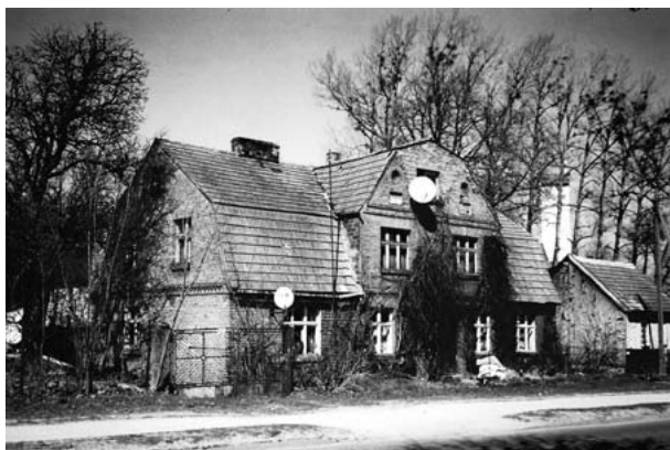
Tak wyglądała kiedyś ulica Sabata (obiekt rozebrany)
