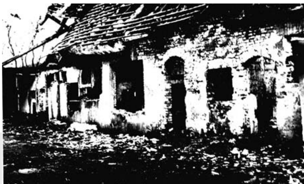
Rumia, lata 70. Zajazd przy ul. Sobieskiego w trakcie rozbiórki
