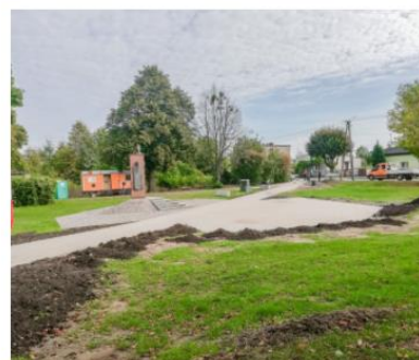
Przebudowa parku przy ul. Derdowskiego/Wybickiego
