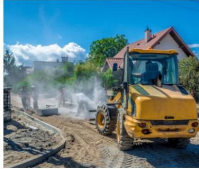
Budowa ul. Konopnickiej
