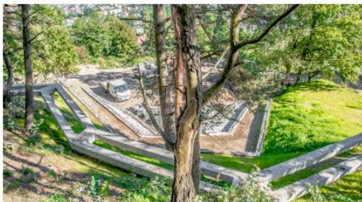
Prace rewitalizacyjne na Górze Markowca
