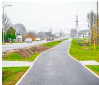
Ścieżka rowerowa wzdłuż drogi wojewódzkiej
