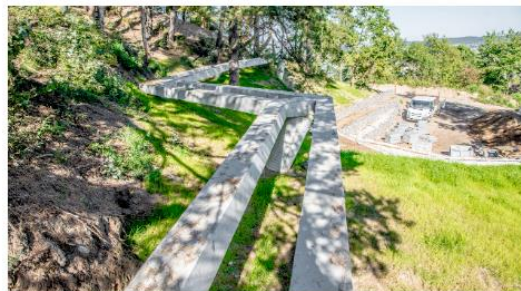
Prace rewitalizacyjne na Górze Markowca
