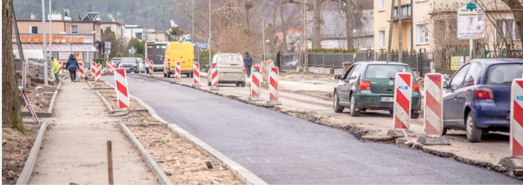
Asfalt na ul. Sabata
